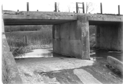
Рисунок 1 - Водосброс открытого типа
