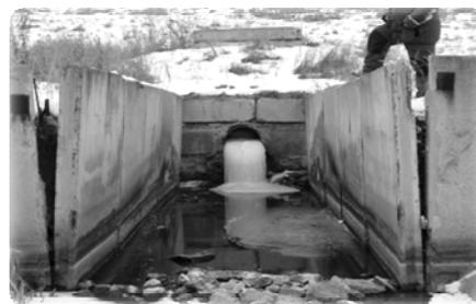
Рисунок 2 - Разрушение плит.
