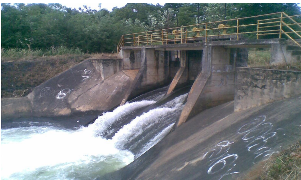
Рис. 4. Водослив на ирригационном канале в Шри-Ланке
