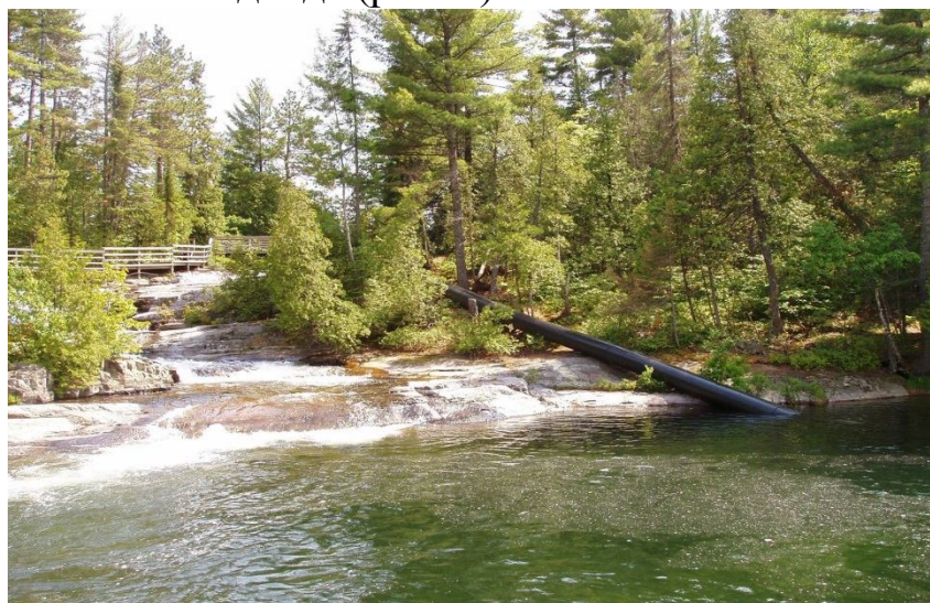
Рис. 5 Деривационная схема мини-ГЭС
