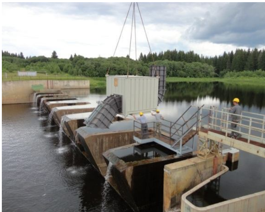
Рис. 1. Установка энергетического блока мини ГЭС на полигональный водосброс р. Нерль
