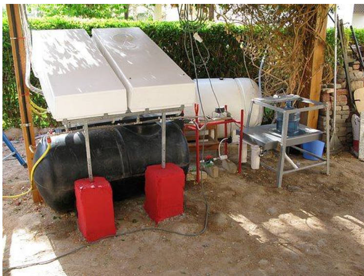
Рисунок – 1 Установка WaterStillar
