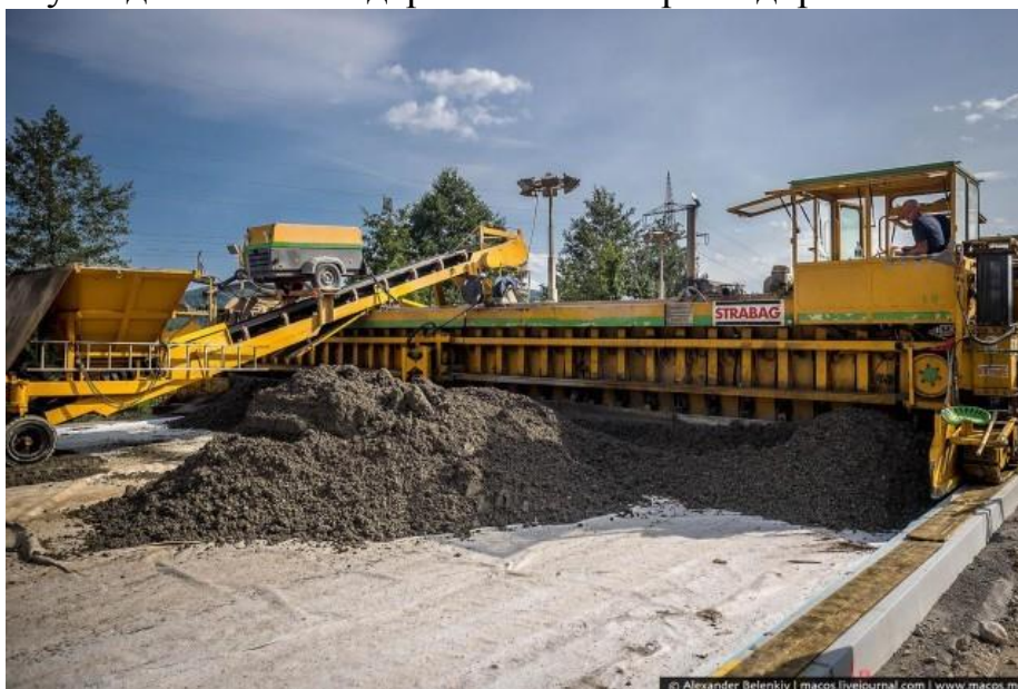
Рисунок 3 – процесс укладки верхнего слоя автобана
