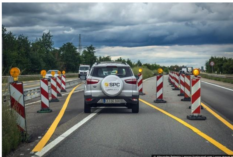
Рисунок 2 – Организация сведения потоков при ремонте одного из направлений на участке A5
