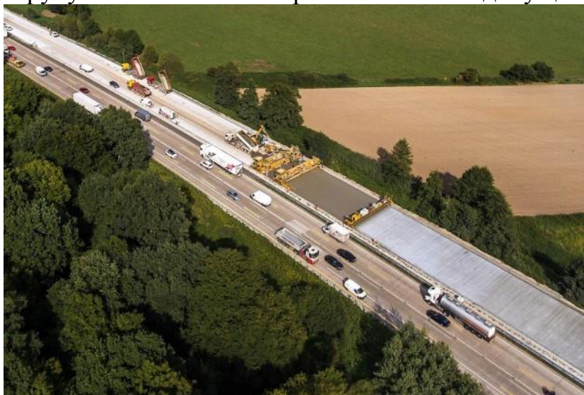
Рисунок 4 – Процесс укладки верхнего слоя полотна
