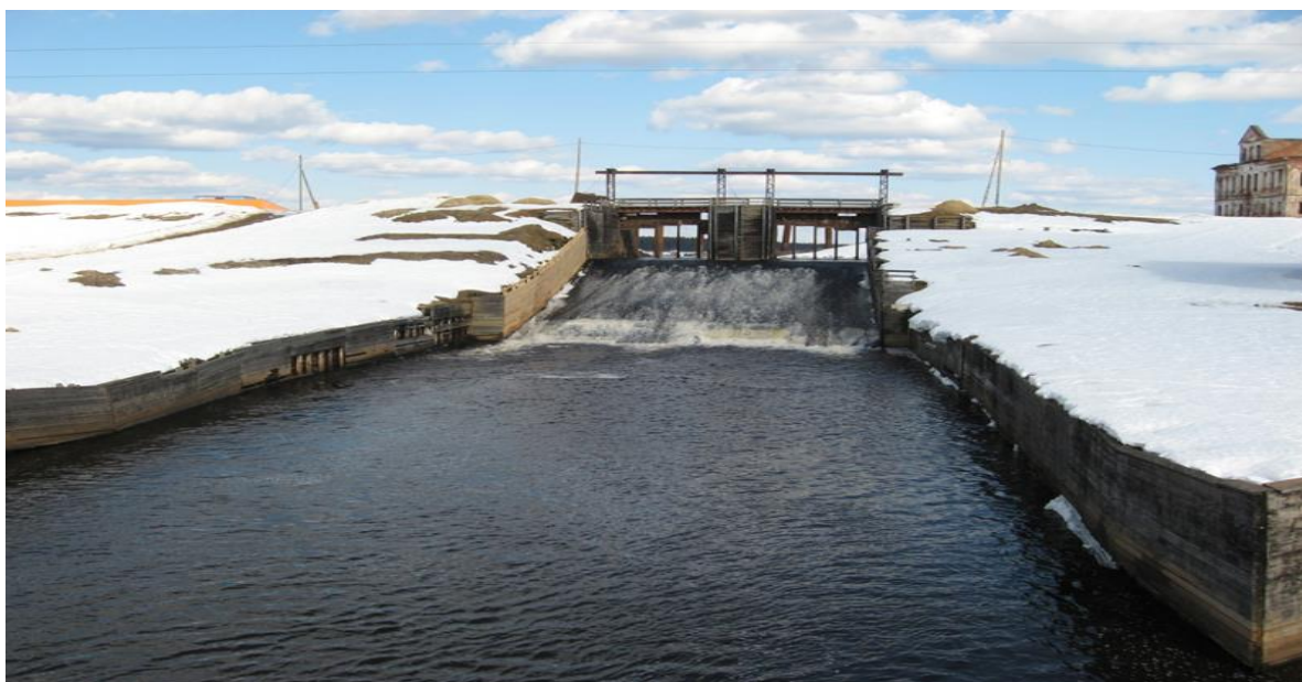
Рисунок 1 – Общий вид ГТС со стороны нижнего бьефа
